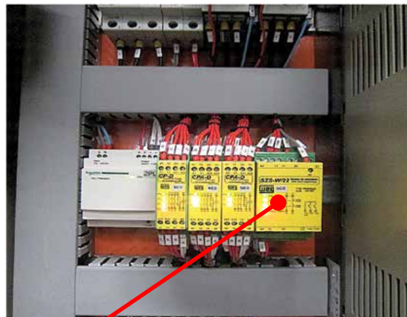
Relé de monitoramento de velocidade zero
