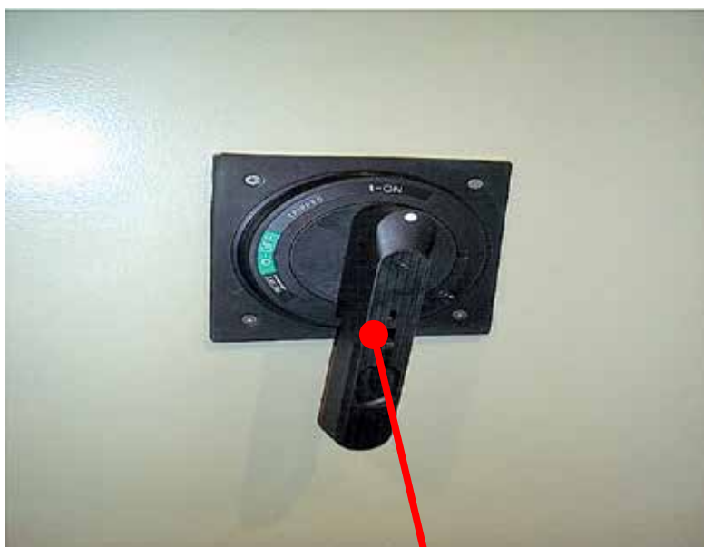
Chave seccionadora que permite o bloqueio
