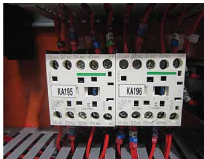
Contactoras de potência ligadas em série para realizar a parada do motor
