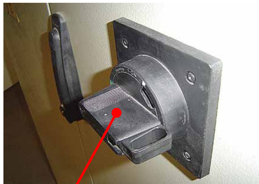
Chave seccionadora que permite o bloqueio
