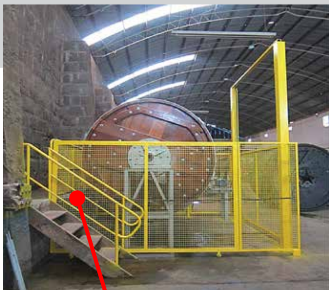
Meio de acesso permanente
