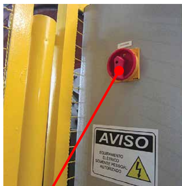
Chave seccionadora que permite o bloqueio
