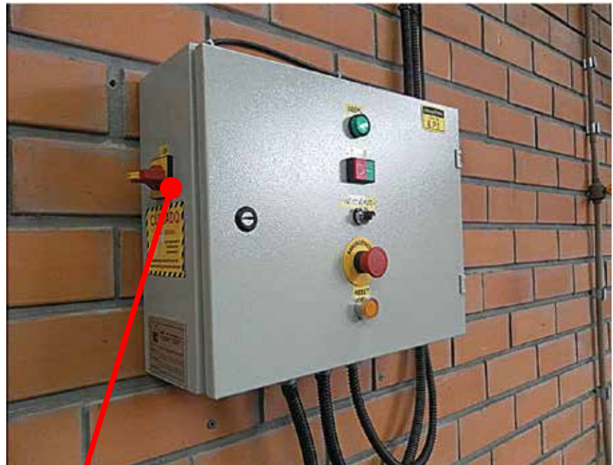
Chave seccionadora que permite o bloqueio
